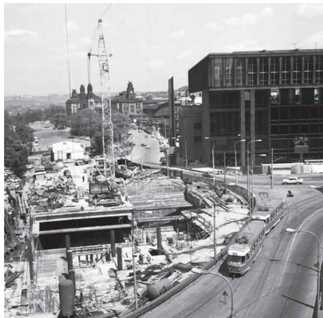
Výstavba stanice metra Muzeum C 1971–1972
