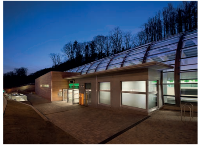
Stanice metra Nemocnice Motol (foto: Ester Havlová)
