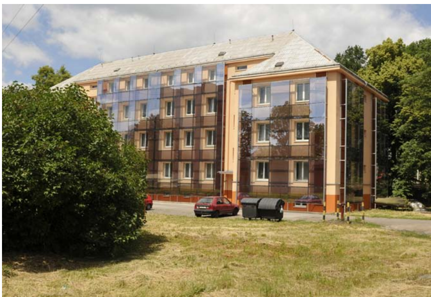
► Zvukově odrazivá fasáda ubytovny
