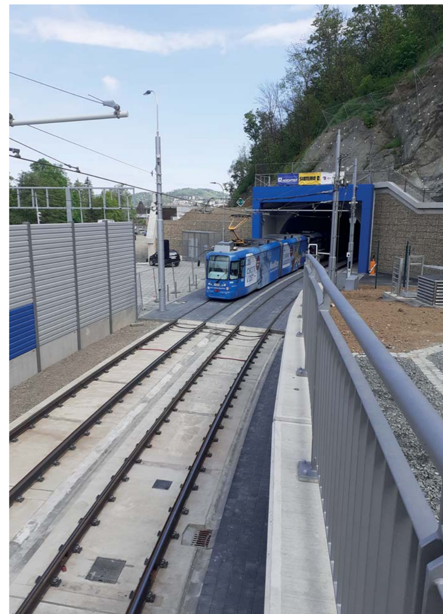
Jižní portál a navazující úsek zřízený jako pevná jízdní dráha
