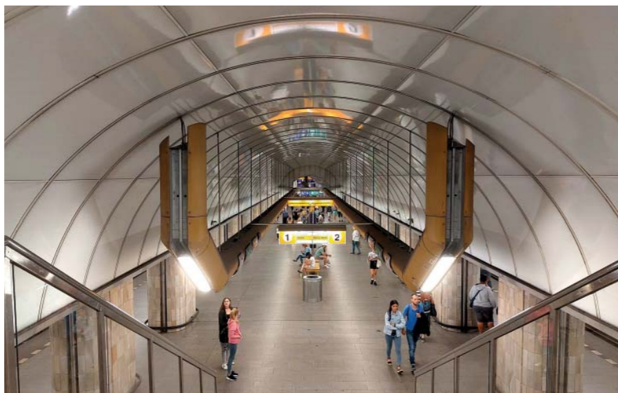
Trasa I.B - stanice Můstek - přestupní ražená sloupová stanice se střední rozšířenou lodí. Architekt: Jarmil Srpa, Miroslav Suchý.
