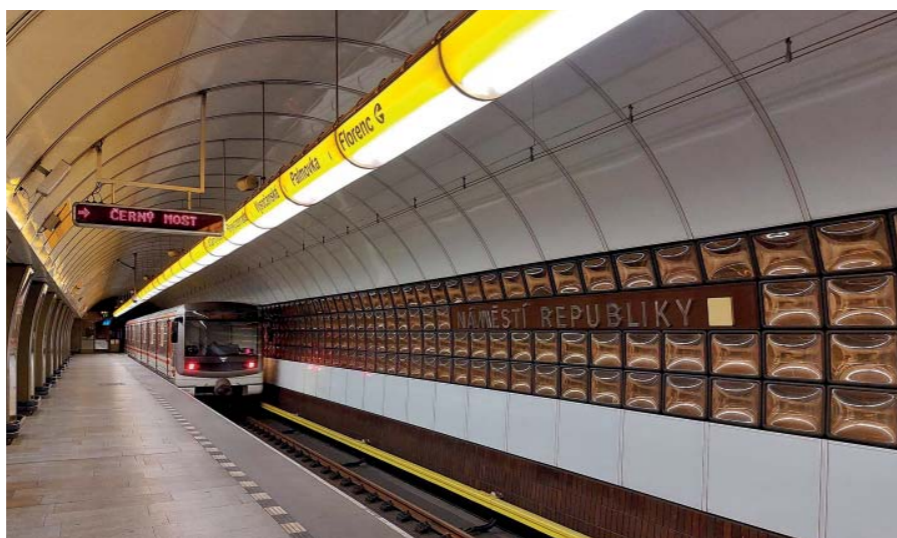
Trasa I.B - stanice Náměstí Republiky - trojlodní ražená pilířová stanice s unikátní stěnou za kolejištěm ze skleněných tvarovek. Architekt: Anna Hübschmannová, Evžen Kyllar. Skleněné tvarovky: Václav Cíglar.
