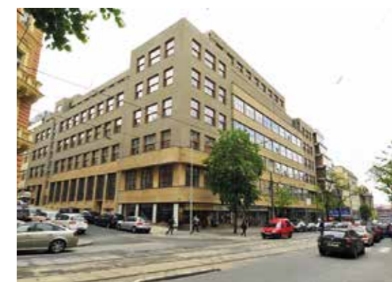
2010 / Rekonstrukce budovy Českého rozhlasu 2003 - 2010
