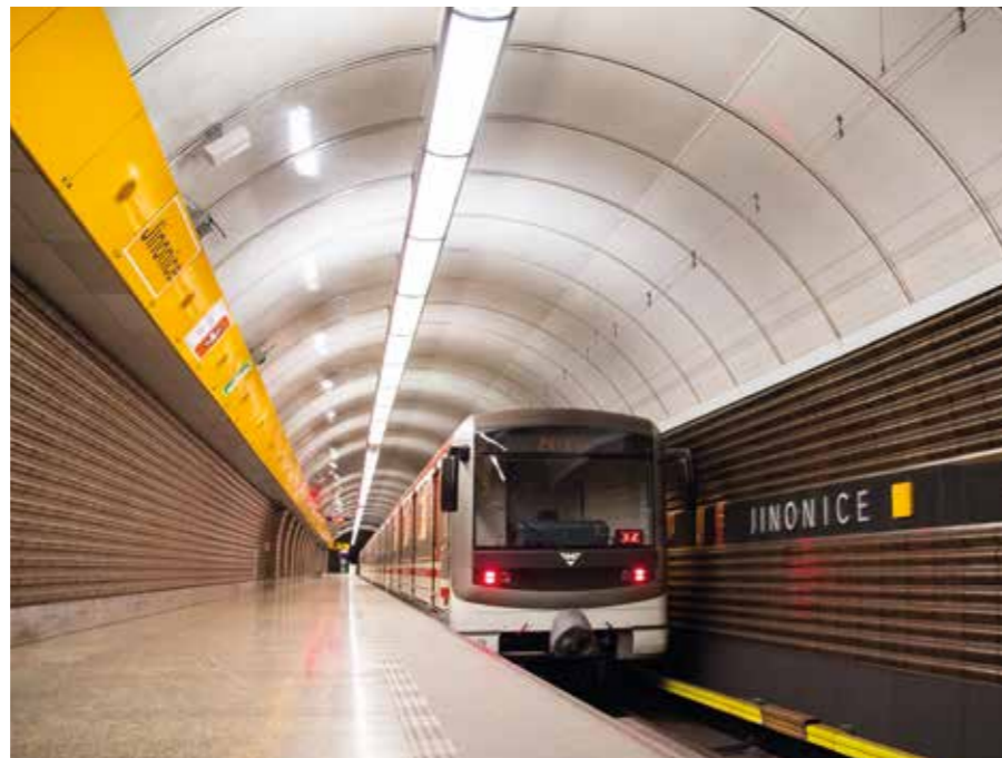
2018 / Rekonstrukce stanice metra Jinonice
