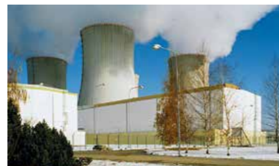
2004 / JE Dukovany - mezisklad vyhořelého jaderného paliva 2003 - 2004
