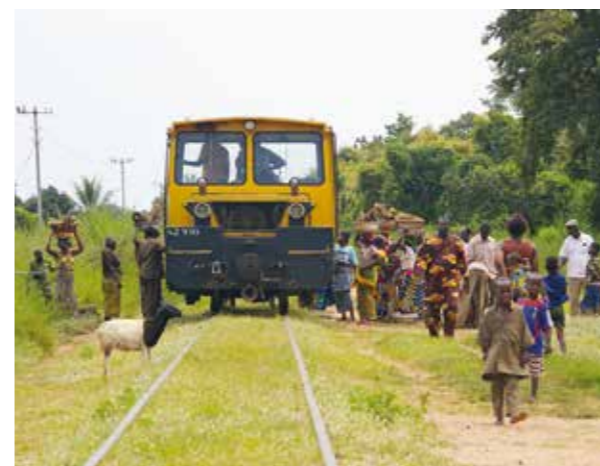
2011 / Rekonstrukce trati Benin - Niger 2009 – 2011
