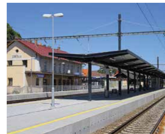
2015 / Modernizace trati Veselí - Soběslav
