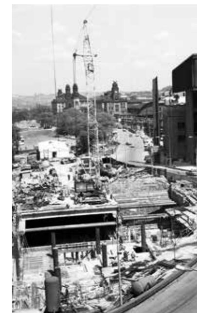
1972 / Výstavba stanice Muzeum C
