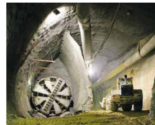
2012 / Ražba tunelů štítem na trase A
