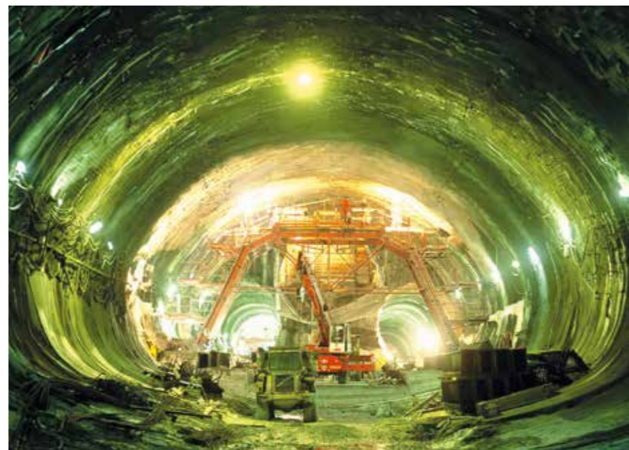
2002 / Metro IV.C1 Nádraží Holešovice - Ládví, výstavba stanice Kobylisy
