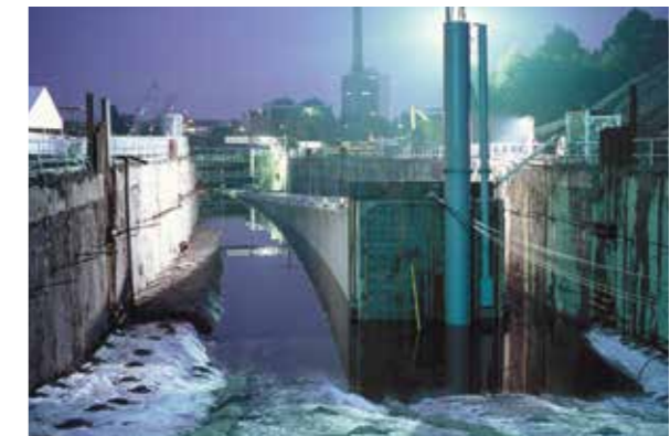
2002 / Metro IV.C1, naplavané tunely pod Vltavou
