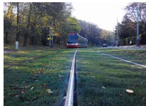
2014 / Rekonstrukce tramvajové trati Střešovická
