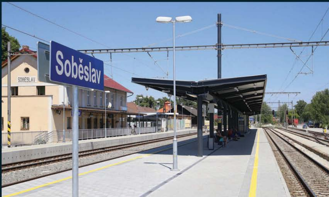
Rekonstrukce železniční stanice Soběslav
