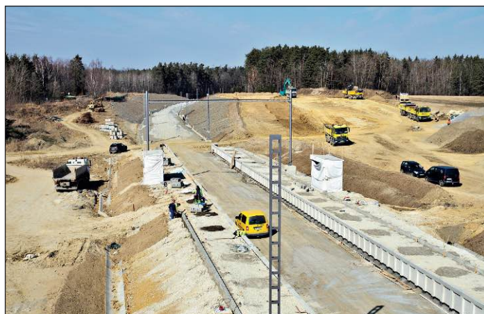
Pohled na silniční nadjezd pro místní komunikaci u nové zastávky Doubí u Tábora. Silnice původně procházející prostorem zastávky byla vyzvednuta na násep, takže nové přemostění současně propojuje obě nástupiště zastávky, jejíž výstavba je zachycena na snímku dole. Trať se pak pravým obloukem napojuje do původní stopy směrem k Plané nad Lužnicí.
