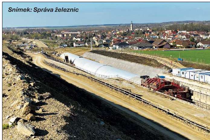
Pohled od severu na výstavbu Zvěrotického tunelu v dubnu 2021, na pozadí je město Soběslav. Tunel je hloubený, jeho ostění bylo zhotoveno v otevřené jámě.
