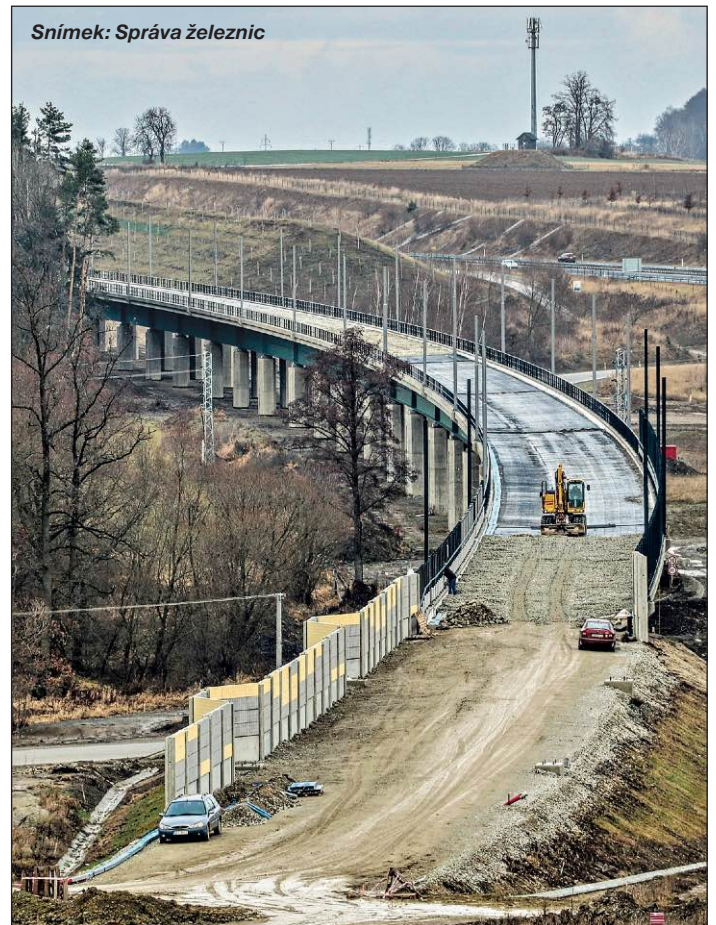
Snímek z konce prosince 2021 přibližuje stavbu mostu přes údolí Černoického potoka pohledem od severního portálu Zvěrotického tunelu.
