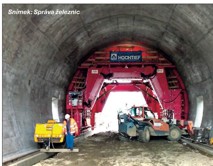
Pohled do vnitřku tunelového ostění na vnitřní část posuvného bednění od firmy PERI. Tento dvoukolejný tunel má světlý průměr 5 700 mm, jeho spodní část byla zhotovena buď na patkách (jako na snímku), nebo s vybetonovanou spodní klenbou v geologicky složitějších částech. Během betonáže byly do ostění umístěny chráničky pro kabeláž nouzového osvětlení atp.
