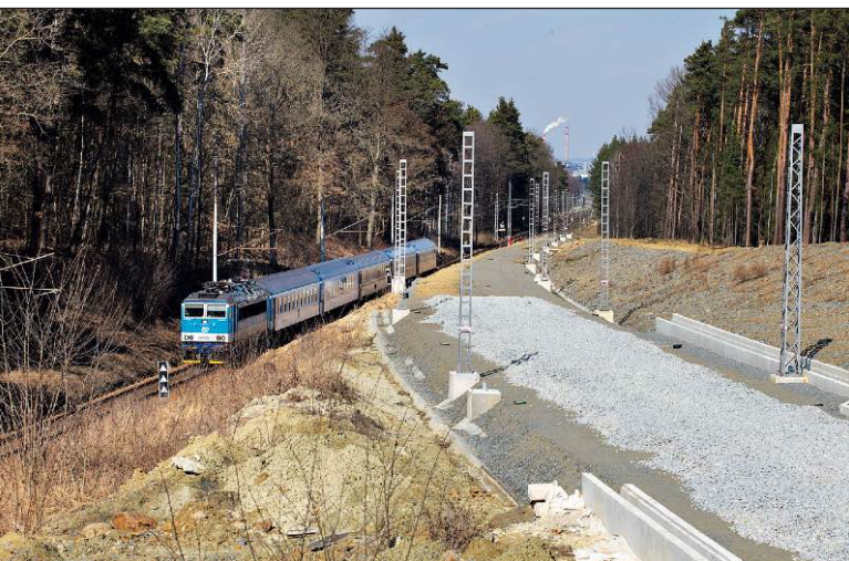
Vlak R 713 „Vltava“ Praha-Holešovice - České Budějovice s lokomotivou 362.053 poblíž již zrušené odb. Doubí, kde se přeložka připojuje k již dříve modernizované trati. Patrný je i výškový rozdíl obou tratí, přičemž přeložka klesá ve sklonu 11,8 ‰.
