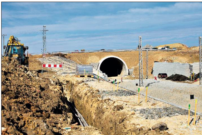
Při severním okraji města Soběslav se nachází jižní portál Zvěrotického tunelu, jehož délka činí 370 m. Zde již vidíme provedený zásep tunelu, nad portálem je též budována přeložka místní komunikace.
