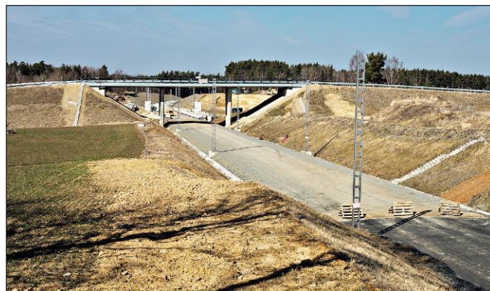
Pohled na silniční nadjezd pro místní komunikaci u nové zastávky Doubí u Tábora. Silnice původně procházející prostorem zastávky byla vyzvednuta na násep, takže nové přemostění současně propojuje obě nástupiště zastávky, jejíž výstavba je zachycena na snímku dole. Trať se pak pravým obloukem napojuje do původní stopy směrem k Plané nad Lužnicí.
