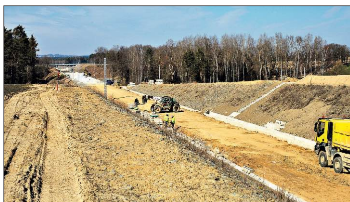
Pohled severním směrem na budované těleso nové tratě. Na pozadí je patrný silniční nadjezd u zastávky Doubí u Tábora. Světlejší část traťového tělesa signalizuje navážení štěrku traťového svršku.
