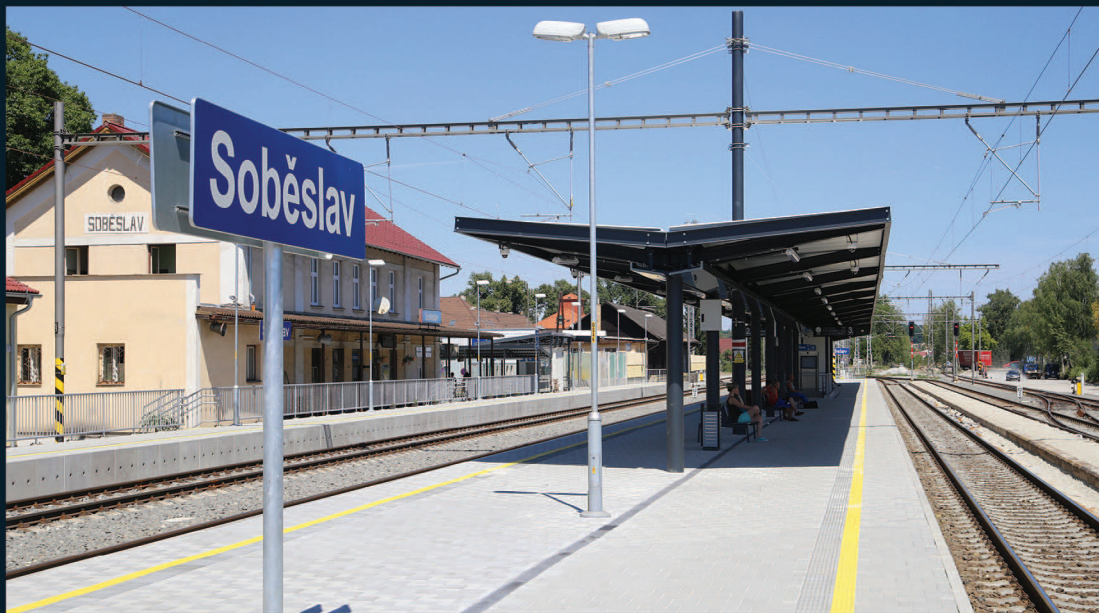
Rekonstrukce železniční stanice Soběslav
