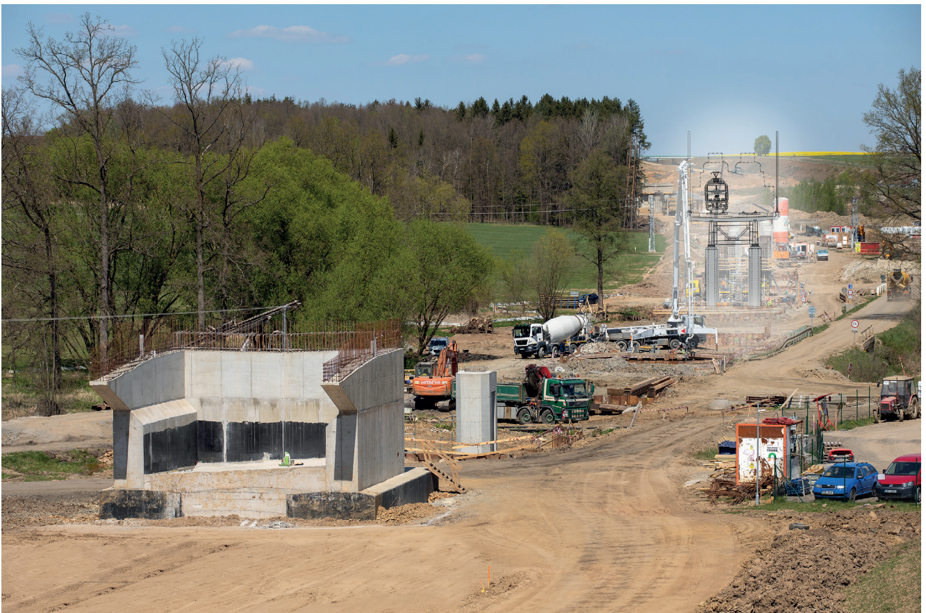
Součástí stavby Modernizace trati Soběslav – Doubí u Tábora je přes 850 m dlouhá železniční estakáda přes údolí Černovického potoka. V době zprovoznění by se měla stát třetím nejdelším železničním mostem v České republice. Projekt estakády prošel z důvodu budoucího zavedení rychlosti 200 km/h rozsáhlou revizí. Po statickém přepočtu bylo možno potvrdit původní rozsah založení, ke změnám však došlo u ložisek a dále u protihlukové stěny, která je kotvena do zábradelní římsy. Na snímku z dubna 2020 se zakresleným příčným profilem v místě jednoho z pilířů je patrný rychlý postup výstavby, který byl zahájena přípravními pracemi v říjnu 2019. Most realizují společnosti Metrostav a Eurovia.
