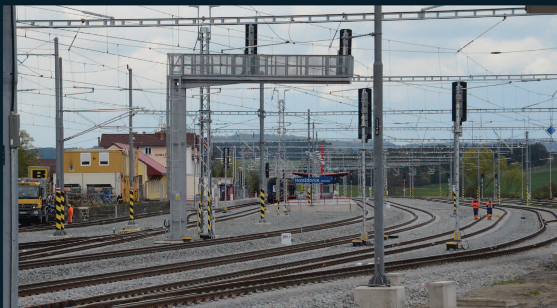
Rekonstrukce železniční stanice Horáždovice předměstí
