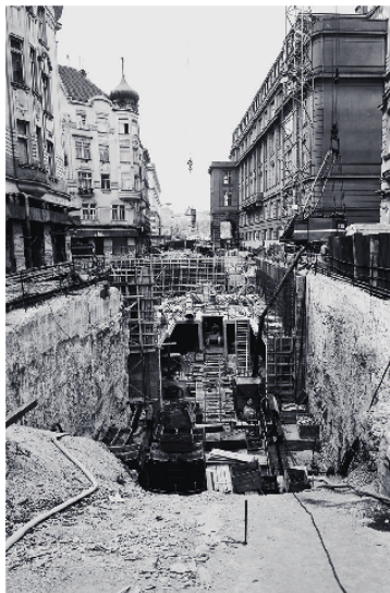
Výstavba linky A pražského metra – stanice Staroměstská, rok 1976
