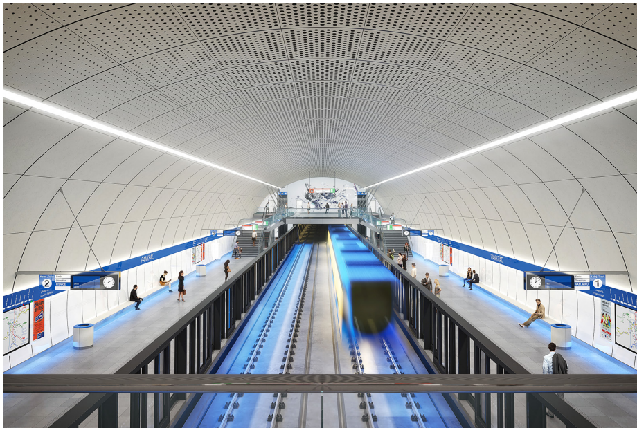
Stanice Pankrác – pohled do interiéru
