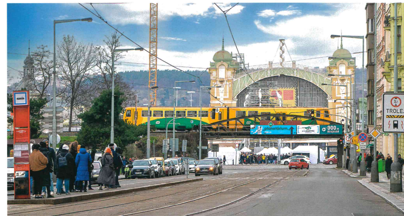
Stávající ocelový most u Výstaviště – poslední den v provozu (11. 3. 2023).
