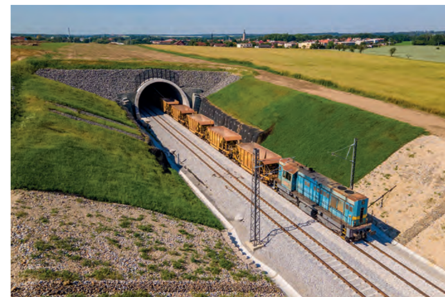
Stavba obsahuje i kratší Zvěrotický tunel. Na snímku je zachycen jeho severní portál a z něj vyjíždí pracovní vlak, zajišťující zaštrkávání železničního svršku. Na horizontu dominuje věž kostela sv. Petra a Pavla v centru města Soběslav.
