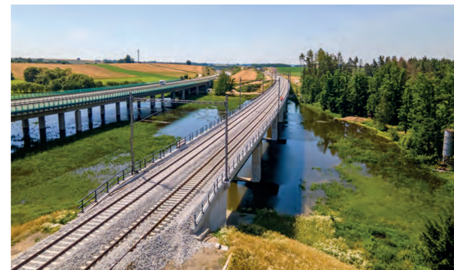
Druhý největší mostní objekt budovaný v rámci stavby je estakáda přes rybník Kamenný. Přes 260 m dlouhá sprážená ocelovo-betonová konstrukce umožnila zachovat rybník s jeho hospodářskými i krajinnými funkcemi.
