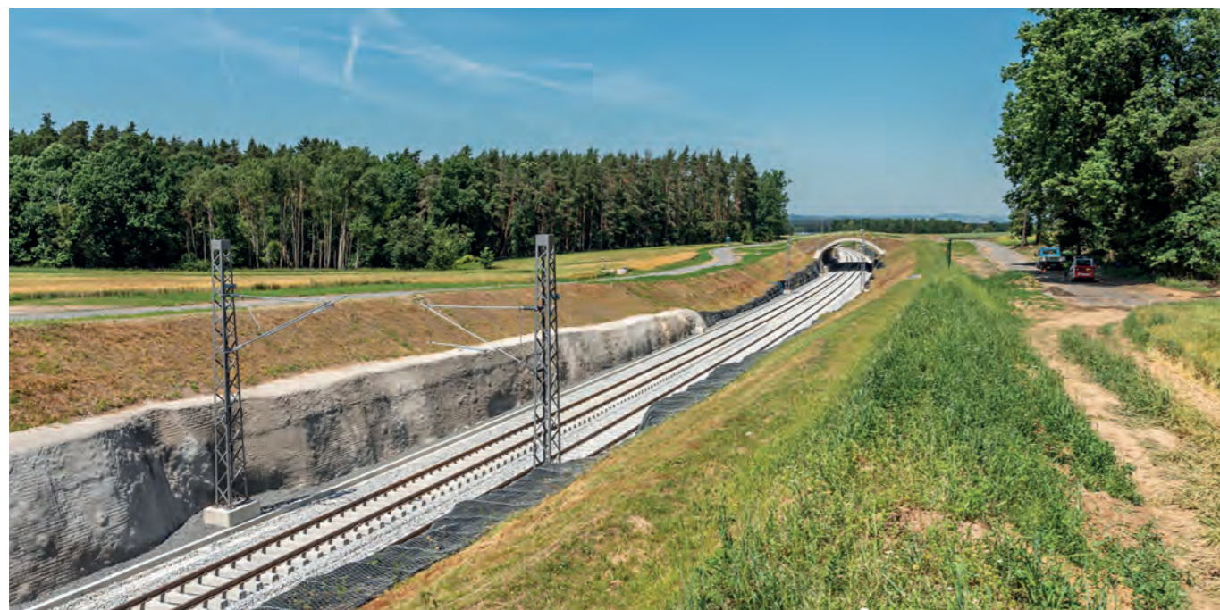
Mezi zastávkami Myslkovice a Doubí u Tábora trať prochází mírně zvlněnou krajinou. Geologická stavba území ovšem pro vedení tratě v zářezu úplně „mírná“ nebyla. Časté střídání pevnějších a méně příznivých hornin znamenalo kromě zajištění svahů pomocí ocelových záchytných sítí, v kombinaci s kotvením a stříkaným betonem. Na snímku z července 2022 se mimo skalního zářezu představuje také přes 60 m široký ekodukt.
