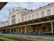
▲ Železniční stanice Mariánské Lázně před rekonstrukcí
