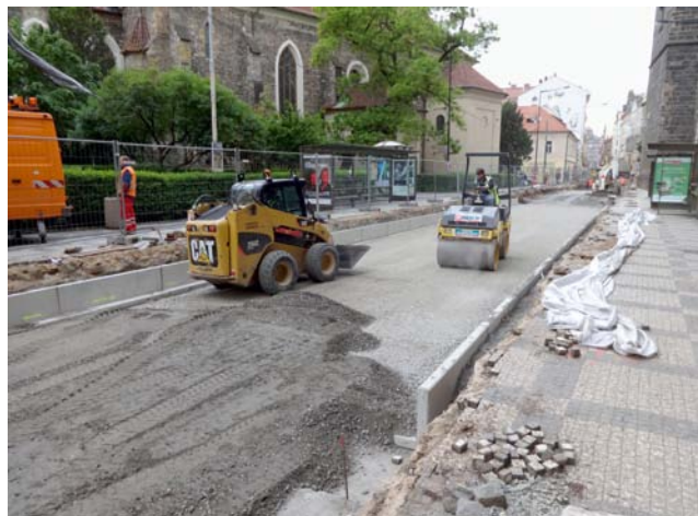
◀ Konstrukční vrstvy před pokládkou asfaltového krytu v Lazarské ulici
