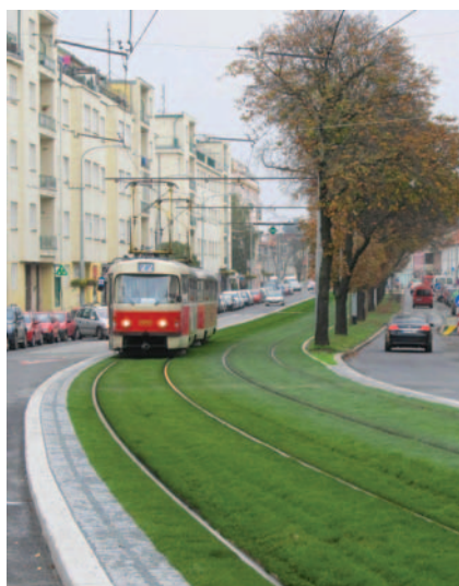
► Zatravněný koleje svršek na Bělohorské
