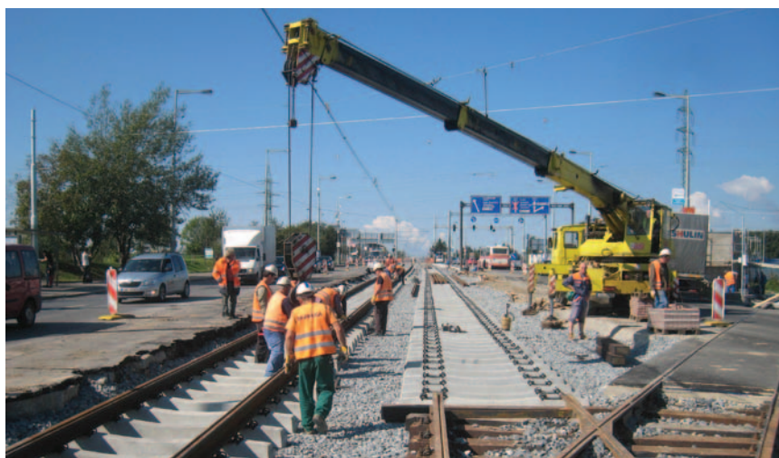
► Pokládka kolejového svršku u smyčky Vypich
