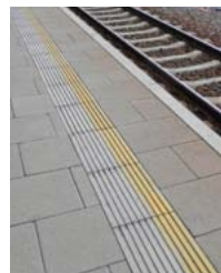
◀ Vodící linie s funkcí varovného pásu, signální a varovný pás na železničním nástupišti
