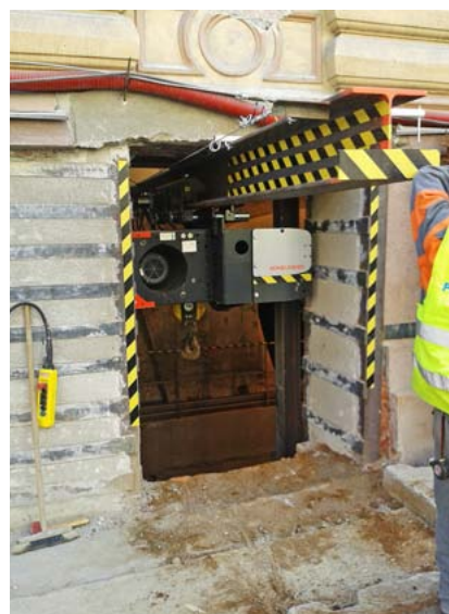
◀ Doprava materiálu z jámy a do jámy probíhá přes probouraný parapet okenního otvoru 1300 x 2200 mm
