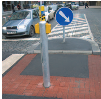
▲ Signální a varovné pásy na přechodu a místu pro přecházení
