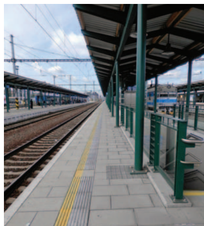
◀ Vodící linie s funkcí varovného pásu, signální a varovný pás na železničním nástupišti
