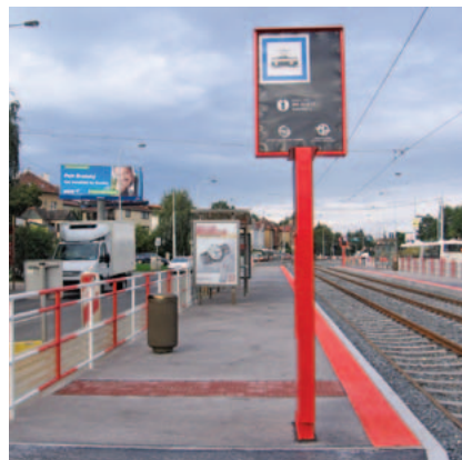
◀ Signální pás a zábradlí se zarážkou pro slepeckou hůl na zastávce veřejné dopravy
