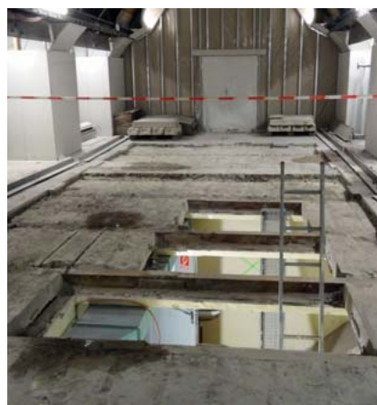
▲ Na nástupišti byly po odstranění dlažeb vybourány otvory pro dojezd dvojice výtahů a pro založení konstrukce únikového schodiště z ÚPCH. Podlaha nástupiště je tvořena prefabrikovanými panely uloženými do ocelových profilů obložených požárním obkladem. Kamennou dlažbu se podařilo odborně demontovat a zpětně položit v celém rozsahu stavby.
