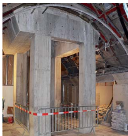
▲ Pro urychlení prací se dodavatel rozhodl pro betonáž konstrukcí ve stanicí ještě před průpichem do přestupní chodby. Dopravní cesta betonové směsi pro nově železobetonové konstrukce byla dlouhá cca 170 m a vedla z prostoru před Zlatým Andělem, kde stál mix a pumpa na beton, po služebním schodišti do úrovně pod vestibulem, odtud kabelovým kanálem prostorem pod eskalátory k tlakovému uzávěru ve stanicí a pak na nástupiště metra. Teprve po dozrání betonu byla zahájena ražba přímo nad stanicí a průpichy na nástupiště metra. Pro podepření klenby stanice jsou navrženy masivní železobetonové konstrukce založené v úrovni pod nástupištěm. Po dokončení izolací v úrovni přestupní chodby byly přetěsněny spáry železobetonových dílců ostění.
