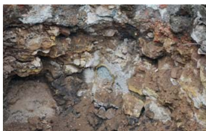
▲ Kanalizace vyplněná betonem po vyhloubení jámy
