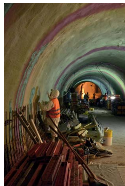
▲ Betonáž přestupní chodby. Dno chodby bylo již vybetonováno v celé délce s vytaženou betonářskou výztuží do klenby. Na klenbě jsou vidět barevně odlišené pracovní spáry stříkané izolace.
