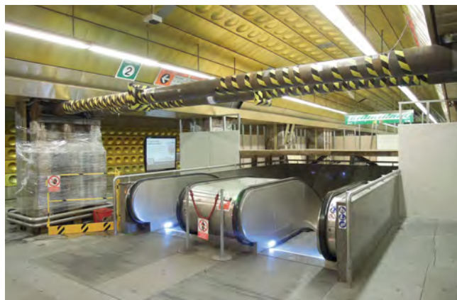
◀ Ocelové rozpěry z trubek mezi pilíři na nástupišti
