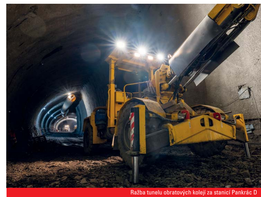
Ražba tunelu obratových kolejí za stanicí Pankrác D
