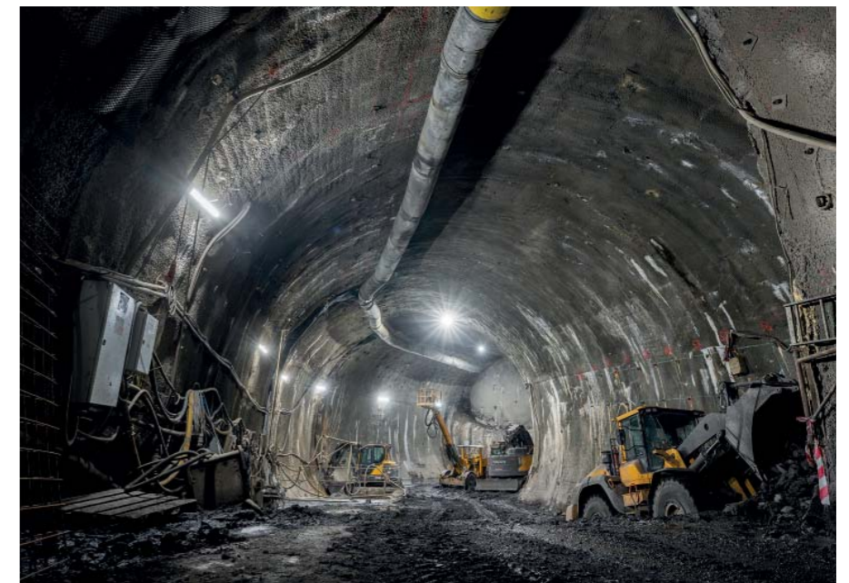
Ražba stanice Pankrác D - přístupní chodba směr Arkády
