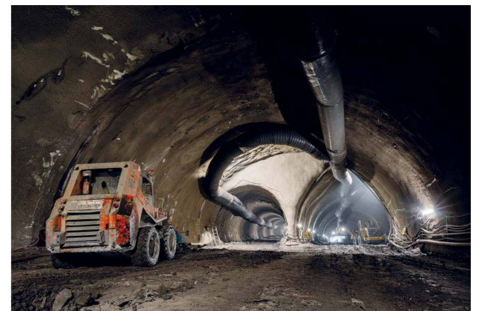
Ražba rozpletu kolejové spojky C - D (vlevo) a jednokolejného traťového tunelu
