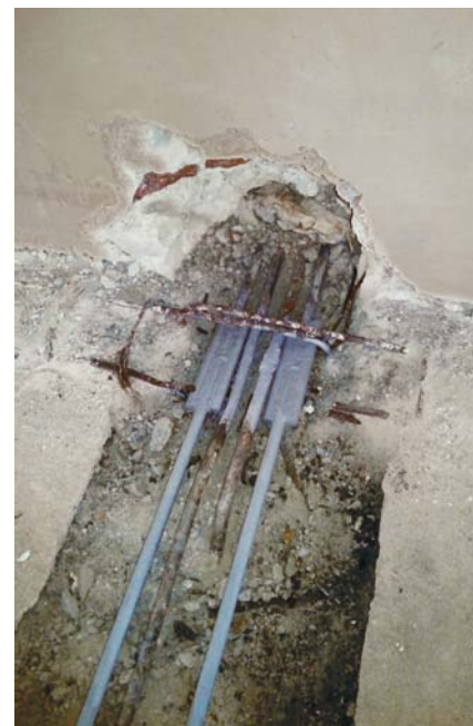
▼ Napojení nových táhel na zhlaví původních
