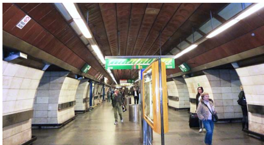
◀ Střední staniční tunel před rekonstrukcí
