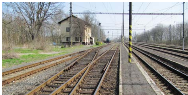
◀ Výpravní budova železniční stanice Mstětice
