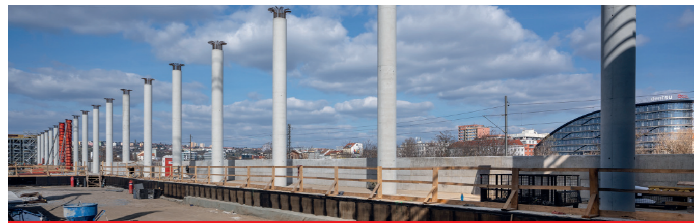
ŽST Praha - Bubny, výstavba nosné konstrukce
