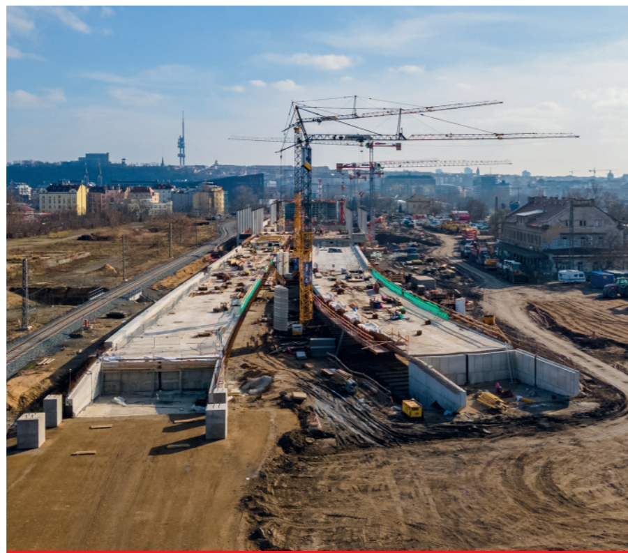
Estakády km 0,450 a km 412,120, vlevo provizorní kolej, vpravo stávající výpravní budova
