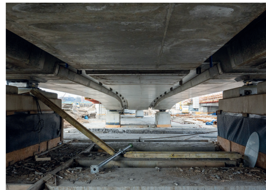
Výstavba estakády, pole nosné konstrukce po odbednění
