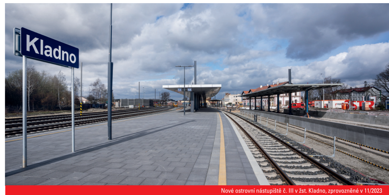
Výstavba žst. Kladno
