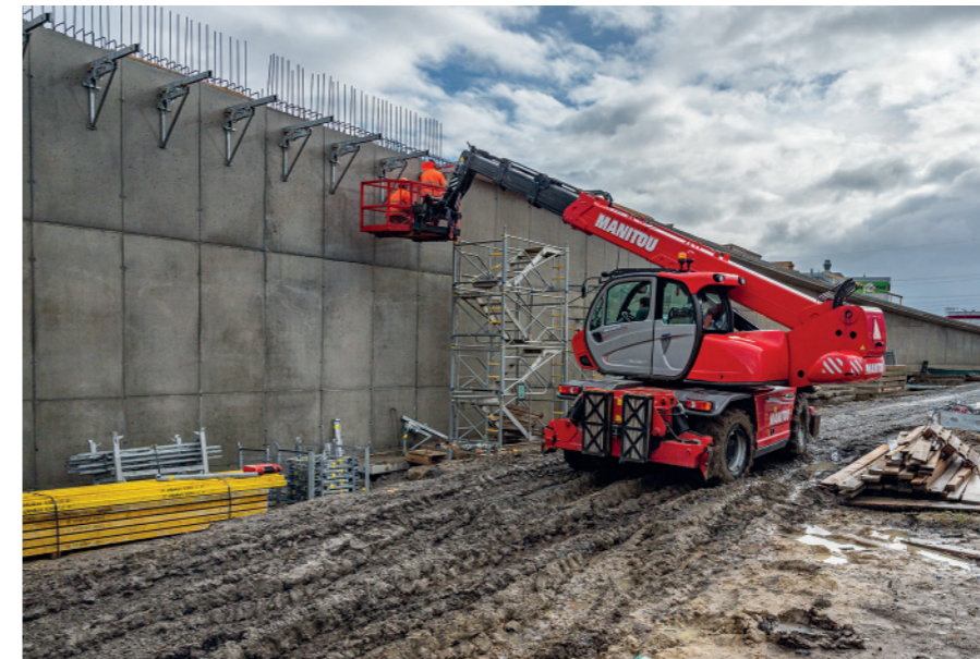
Opěrná zeď v areálu posklizňové linky
