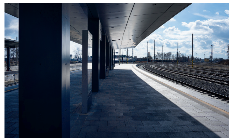
Žst. Kladno - nové ostrovní nástupiště č. III a část kolejiště po modernizaci
