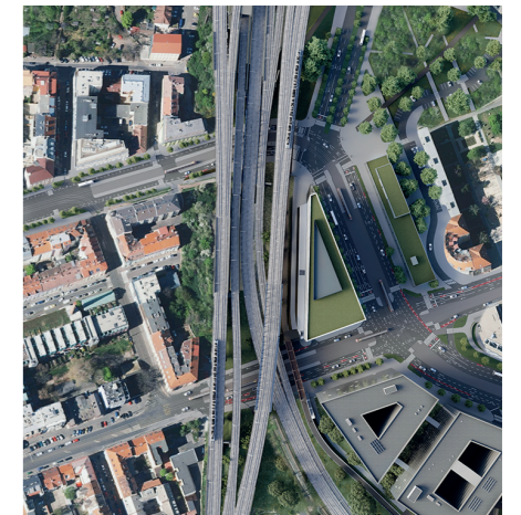
Odb. Balaběnka - centrální část kolejiště s uliční sítí po dokončení městského okruhu
