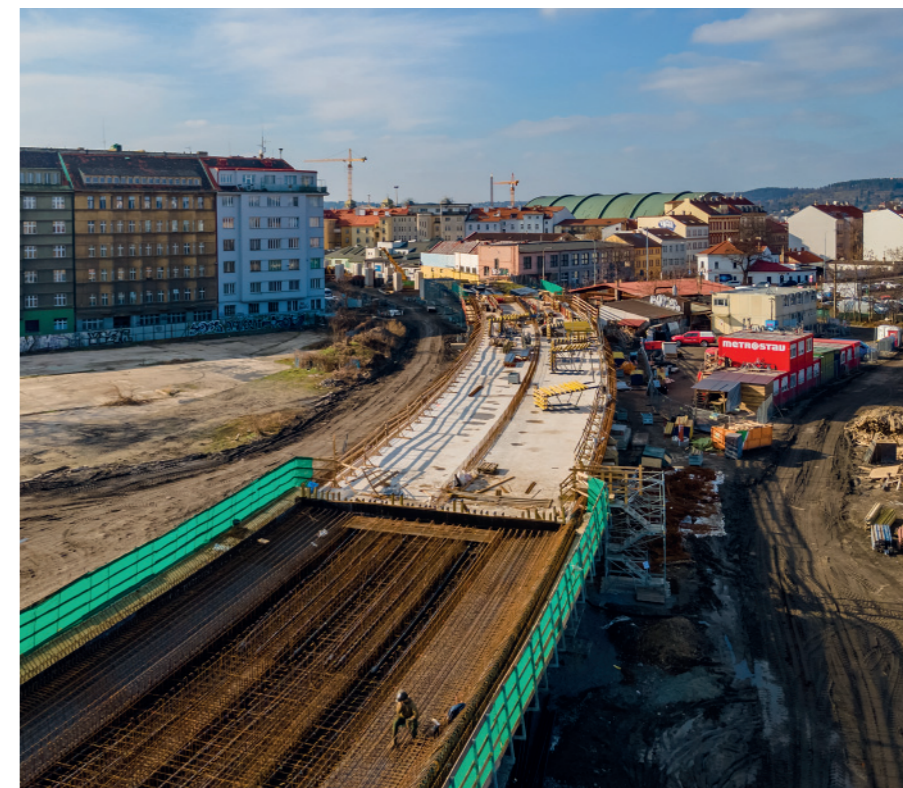
Výstavba estakády směr Výstaviště
