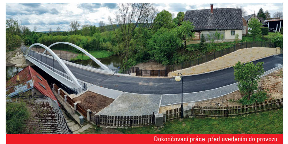
Osazení ocelové části mostovky
